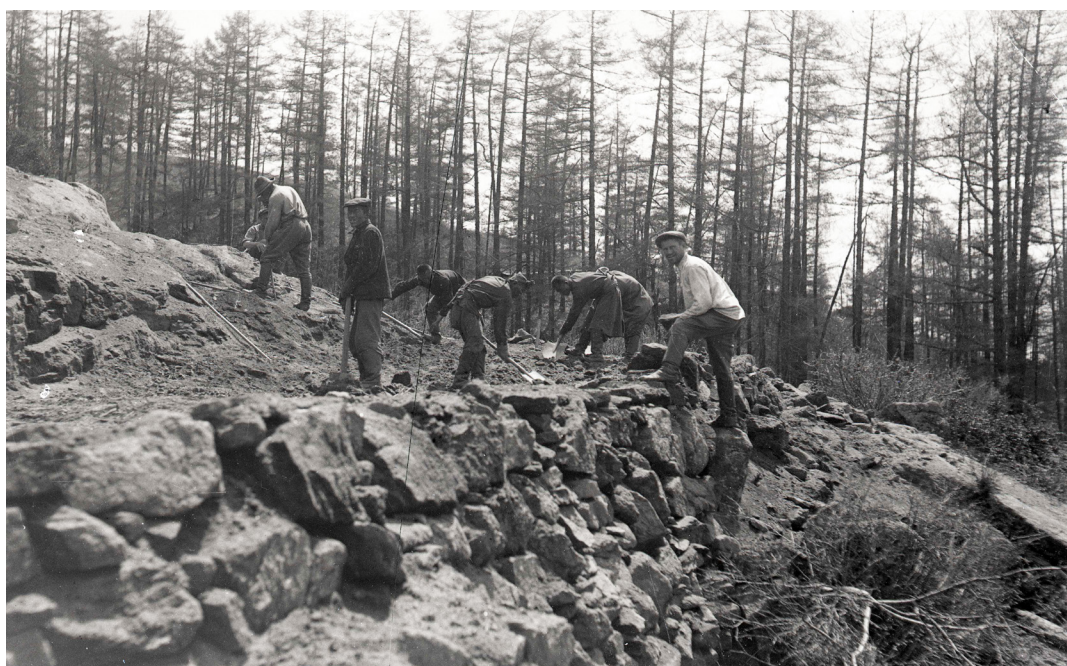
Рис. 3. Скальные работы на перевале через Танну-Ола, дорога Балгазын-Самагалтай, 1935 г.
