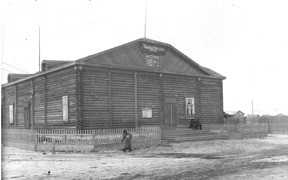
Фото 2. Здание кинотеатра по улице Кочетова. 1937 г. (НМ РТ, КП-11286-1875. Photo 2. The building of the cinema on Kochetov street, 1937 (NM RT, KP-11286-1875).
