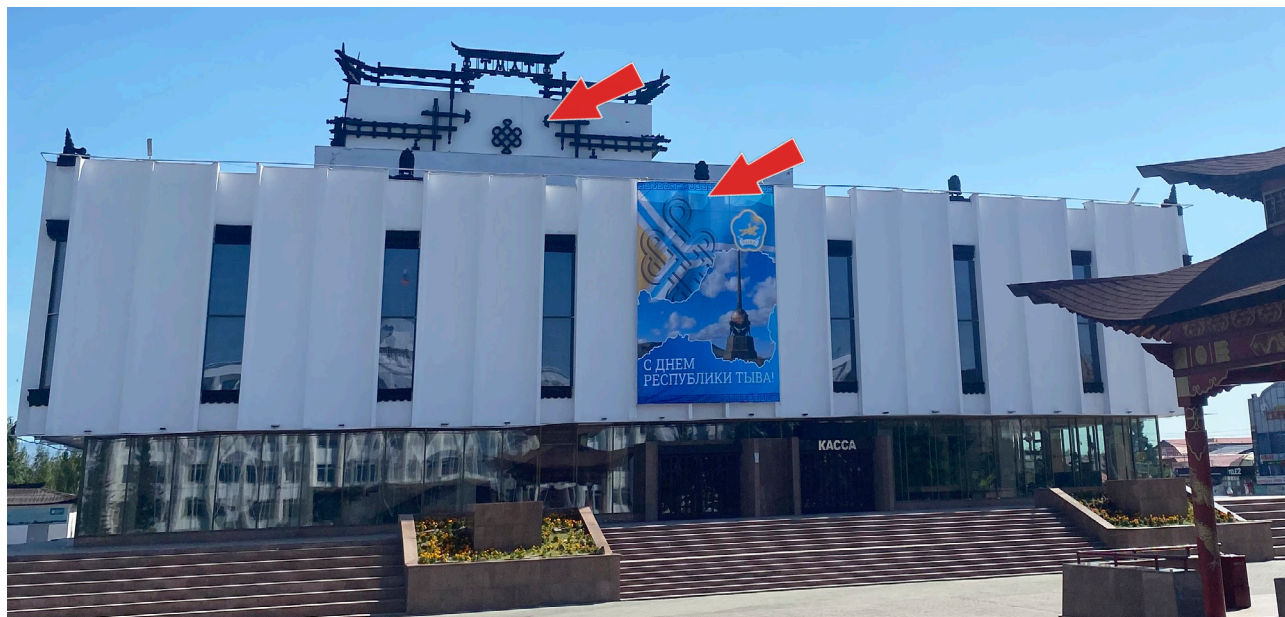
Рис. 3. Передний фасад здания Национального музыкально-драматического театра им. В. Кок-оола Республики Тыва. Орнамент вырезан из дерева и украшает купол здания, также он присутствует на временном баннере. Фото Ш. Майны, г. Кызыл, 2024 г. Fig. 3. The front facade of the building of the V. Kok-ool National Musical and Drama Theater of the Republic of Tuva. The ornament is carved from wood and adorns the dome of the building, and it is also present on a temporary banner. Photo by Sh. Mainy, Kyzyl, 2024.
