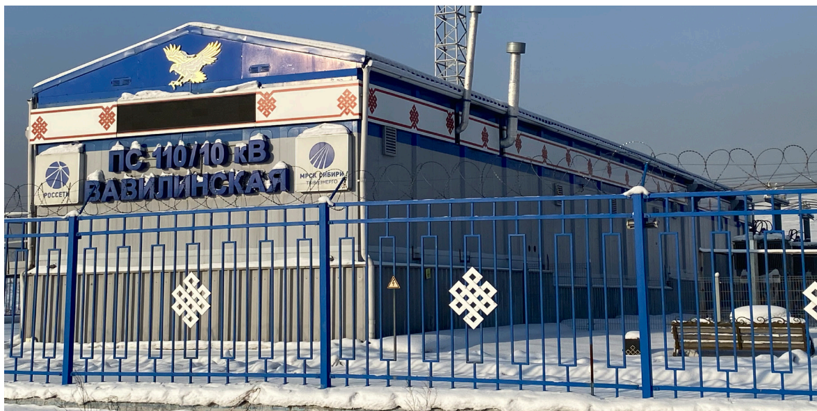
Рис. 8. Фасад подстанции «Вавилинская» компании «Россети Сибирь Тываэнерго». Фото Ш. Майны, г. Кызыл, 2024 г. 8. Facade of the Vavilinskaya substation of Rosseti Siberia Tyvaenergo. Photo by Sh. Mainy, Kyzyl, 2024.
